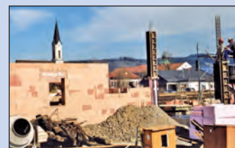
Schon kurz darauf machte der Bau sichtbare Fortschritte...
