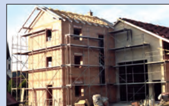
Das Dach wird eingedeckt
