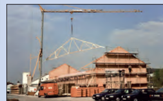
Mitte April werden die Nagelbinder aufgestellt
