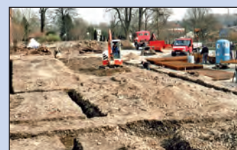
Am 17. März 2010 wurde das Fundament ausgehoben
